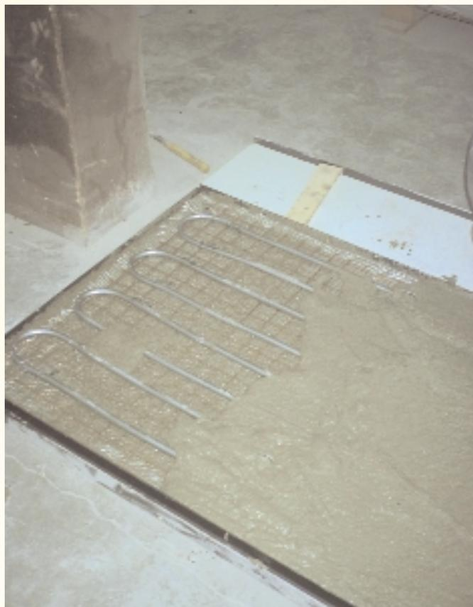
(Bild 12) Herstellen von Klimaplatten mit textiler Bewehrung und Einbauteilen im Gießverfahren.
