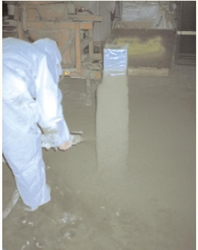
(Bild 11) Vorgemischte Matrix im Spritzverfahren für eine Brandschutzverkleidung.
