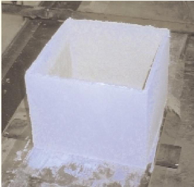
(Bild 15) Ausparungskasten.
