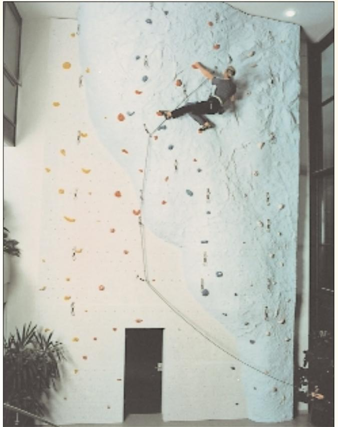
(Bild 4) Kletterwand mit abgebildeter Felsstruktur aus Glasfaserbeton.
