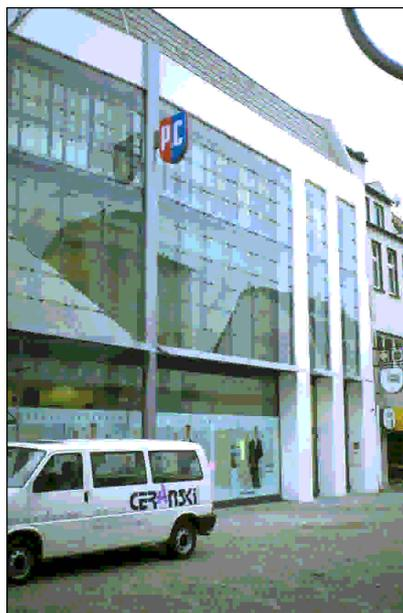
**19** Sichtbeton von Betonfertigteilelementen (Stützen, Träger)
