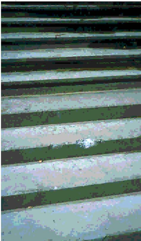
**14** Kantenbeschädigung durch Schlagbeanspruchung
