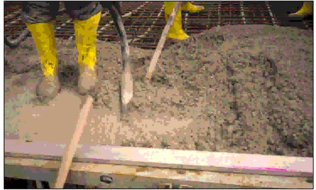
**17** thixotropes Verhalten einer glasfasermodifizierten Betonmischung
