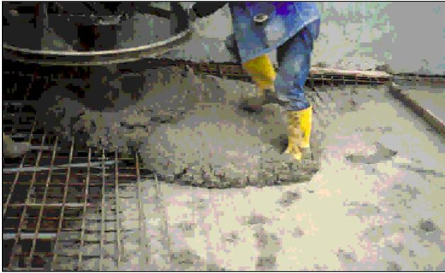
**16** angesteifte Betonmischung durch Beimischung von Glasfasern
