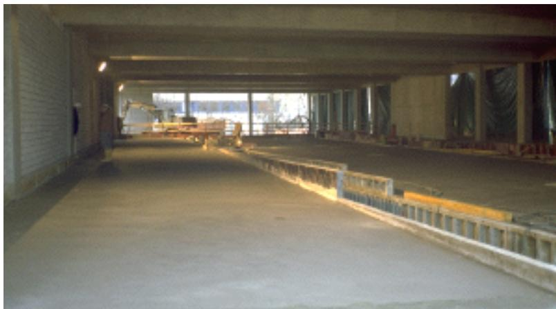
Bild 9: Fugenlose Bodenplatte einer Waschstrasse mit Einbauten
