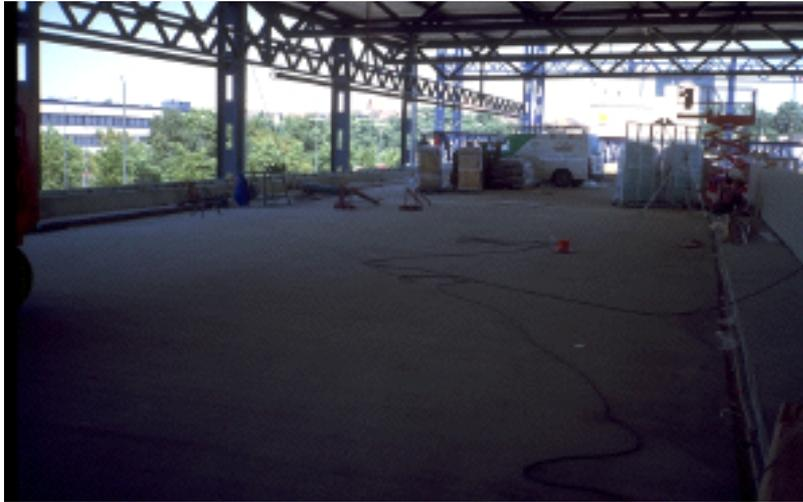
Bild 10: Fugenlose Dichtplatte auf Dämmung
