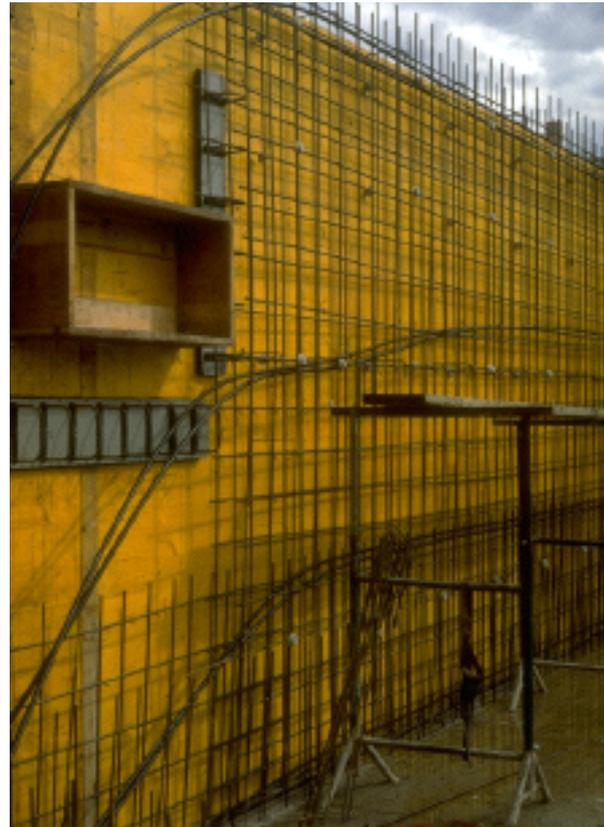
Bild 8: Anordnung der Wandvorspannung
