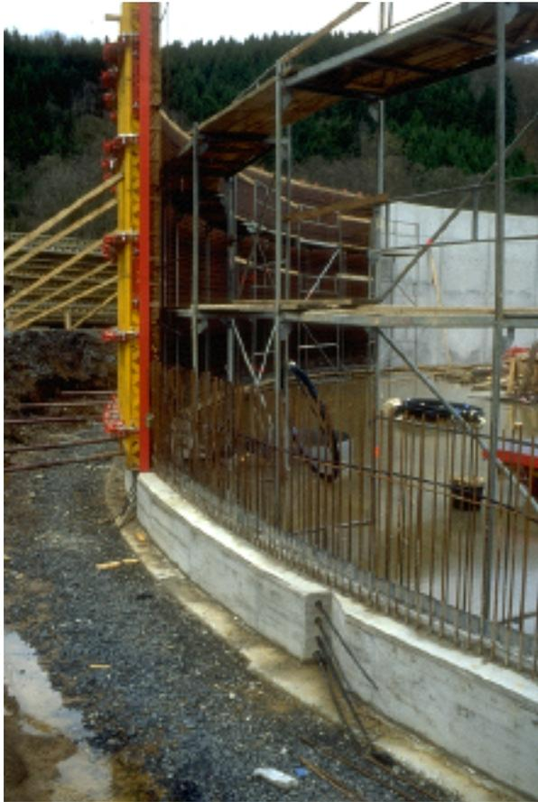
Bild 11: Rundbehälter: Vorspannung für Bodenplatte und Wände
