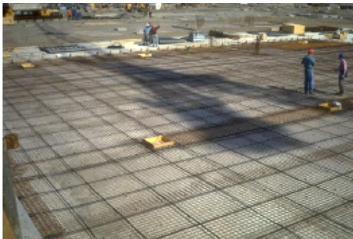
Bild 4: Flächenvorspannung mit Monolithenspannglieder
