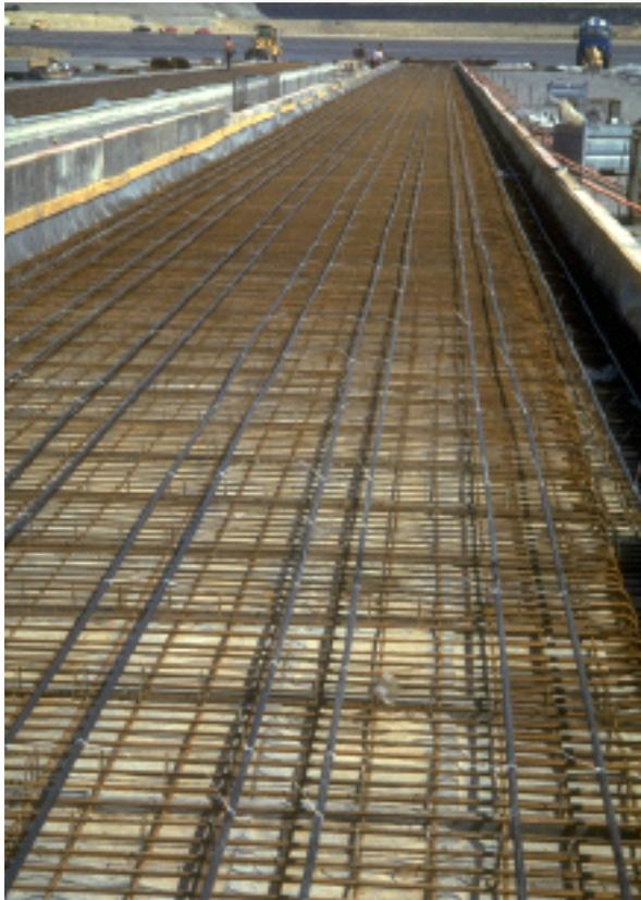
Bild 7: Bosch, Testgelände Boxberg - Vorspannung der Bodenplatte
