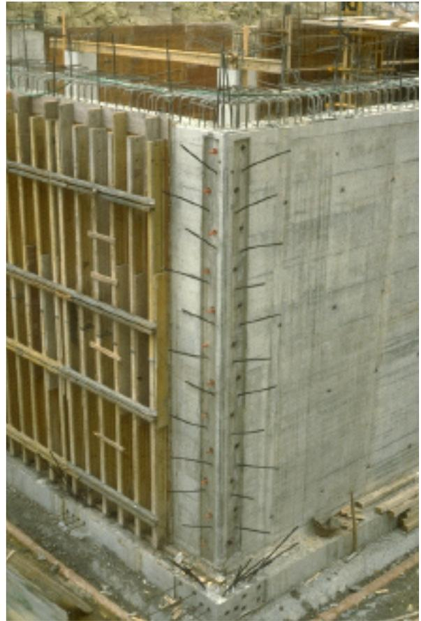
Bild 12: Rechteckbehälter: Vorspannung für Bodenplatte und Wände
